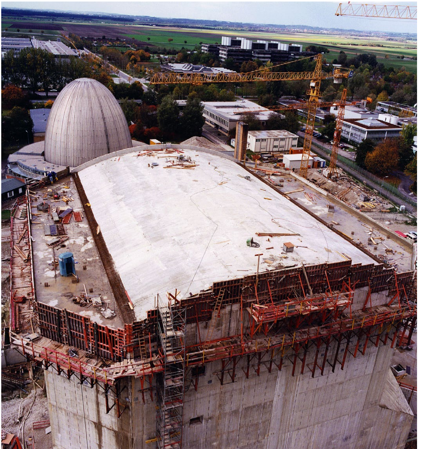
Ein Meilenstein auf der Baustelle – das Dach des Reaktorgebäudes ist geschlossen (1998).
