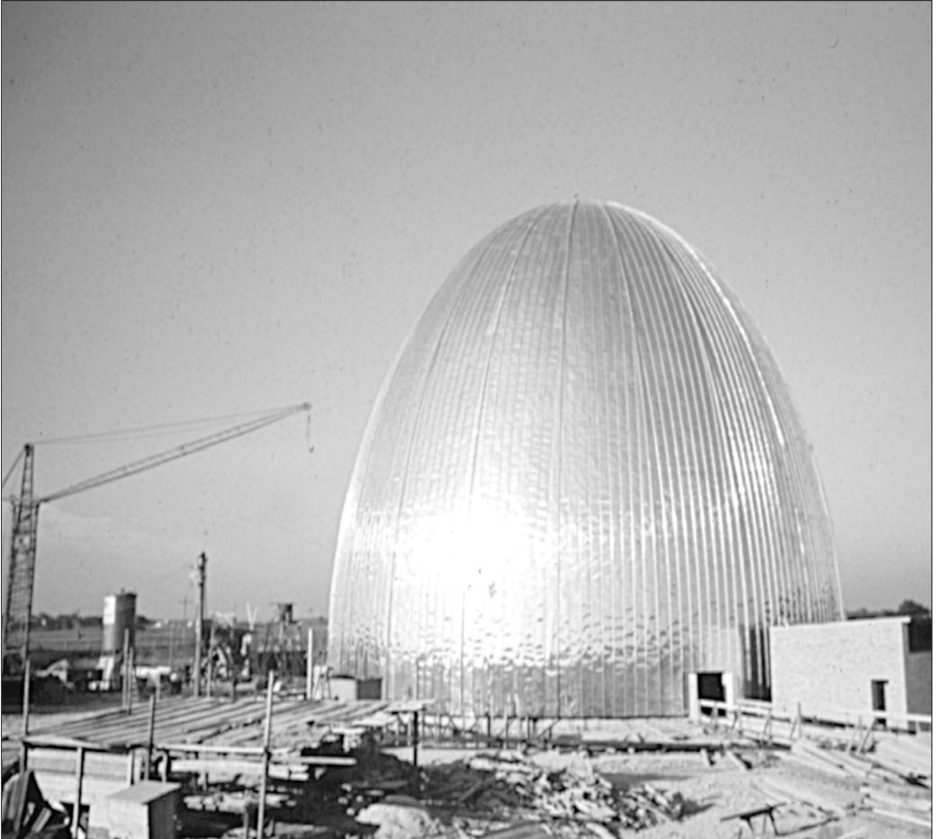
Der Bau am Ringgebäude beginnt
