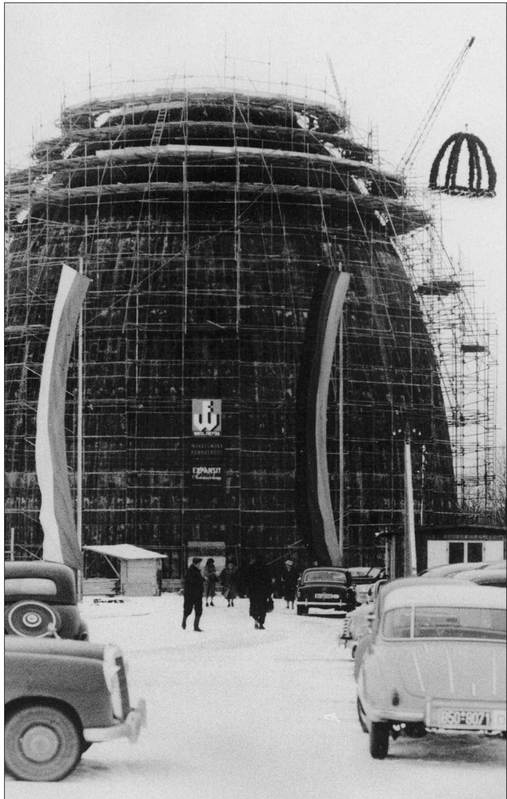
Richtfest am 12. Januar 1957
